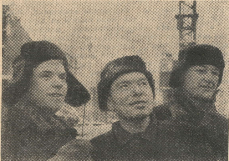
Вологодская область. Строительство Волго-Балта — одного из звеньев глубоководной системы внутренних водных путей европейской части СССР — вступило в решающий период. Недалеко время, когда у гранитных причалов Невы можно будет увидеть белоснежные многопалубные пассажирские лайнеры, крупнотоннажные грузовые теплоходы, пришедшие с Волги, Камы, Дона и других рек.
