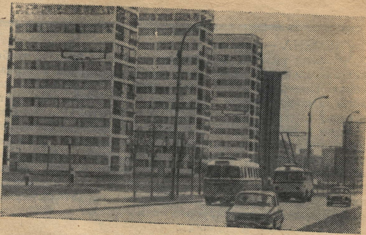
На снимке: новые жалые дома в юго-восточном районе Бухареста—столице Социалистической Республики Румынии. (ТАСС).
