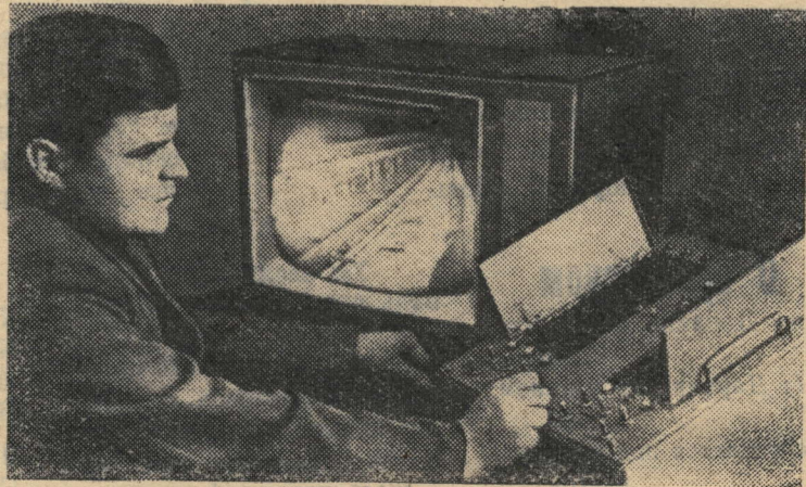
Омская область. Кировско-Омский элеватор (на 164 тысячи тонн зерна) — автоматизированное и механизированное предприятие. Шесть телекамер позволяют диспетчеру следить за приемкой зерна, разгрузкой, погрузкой, маневрированием подвижного состава, за работой транспортеров в цехах...
