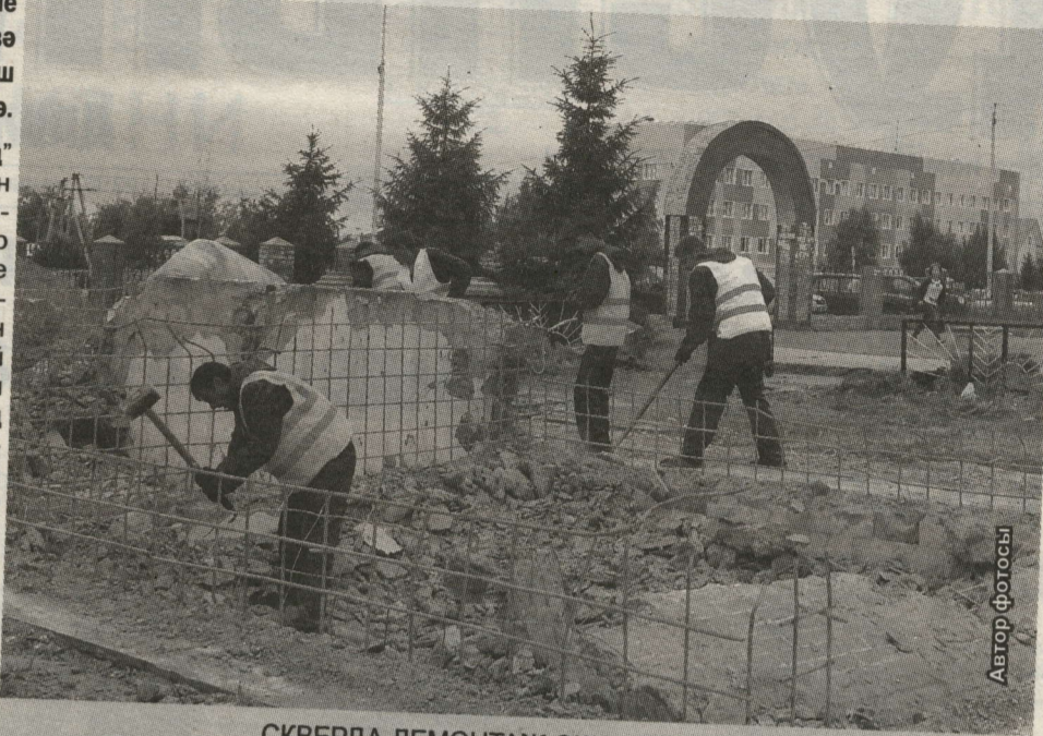
СКВЕРДА ДЕМОНТАЖ ЭШЛӘРЕ БАРА
